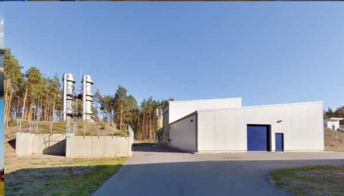
Wasserwerk, WAZV "Elbe-Elster-Jessen"
