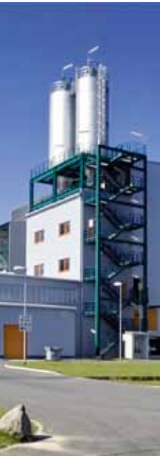
Hi-Bis GmbH, Bitterfeld
